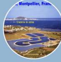
LAGUNAS DE ESTABILIZACIÓN
